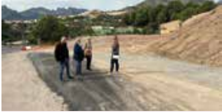
Adequació de l'entorn pròxim al Cementeri Municipal.
