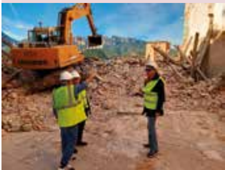
Enderrocament de l'immoble situat en Ctra d'Alacant.
