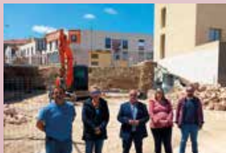
Obres del nou edifici municipal junt als ja construïts.
