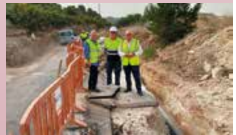
Reparació en la xarxa general d'aigua potable a la partida Margequivir.
