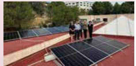
Instal·lació de plaques solars a l'Escola Infantil.
