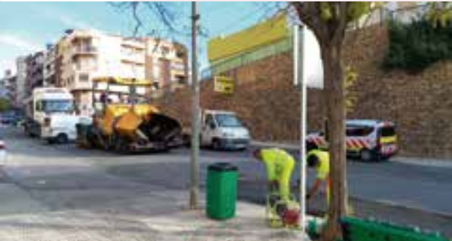
Asfaltat de la carretera CV-715, de Callosa a la Nucia.
