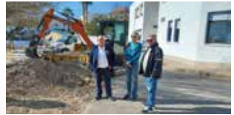
Obres de millora a la zona de urgències del Centro de Salut.
