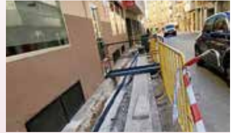
Obres de reparació i millora de la conducció d'aigua a la ctra. de Bolulla
