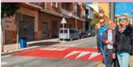
Finalitzen les obres per a instal·lació de reductors de velocitat a la ctra. d'Alacant i a la ctra. d'Alcoi.
